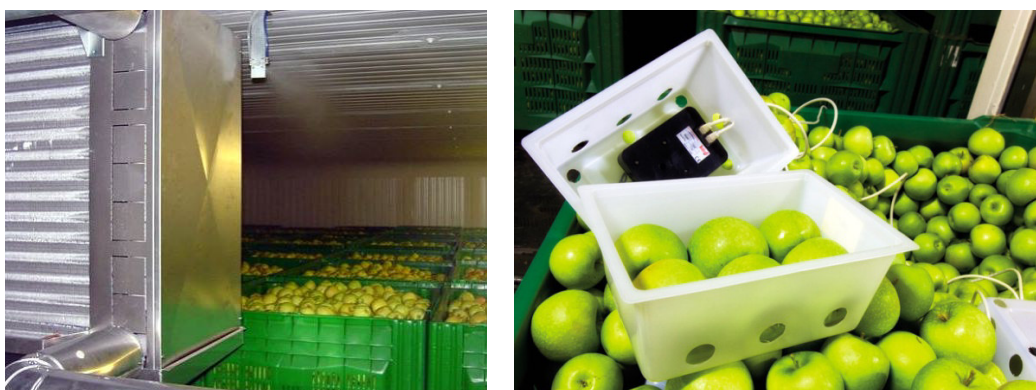
Cámara de Atmósfera Controlada de ISOLCELL (izquierda) y Equipo para medir la fluorescencia de la clorofila
